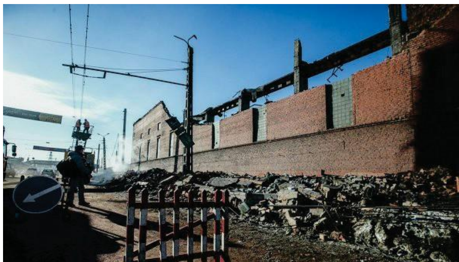
Рис. 1.3. Разрушение зданий взрывом Челябинского метеорита. 2013 г.
